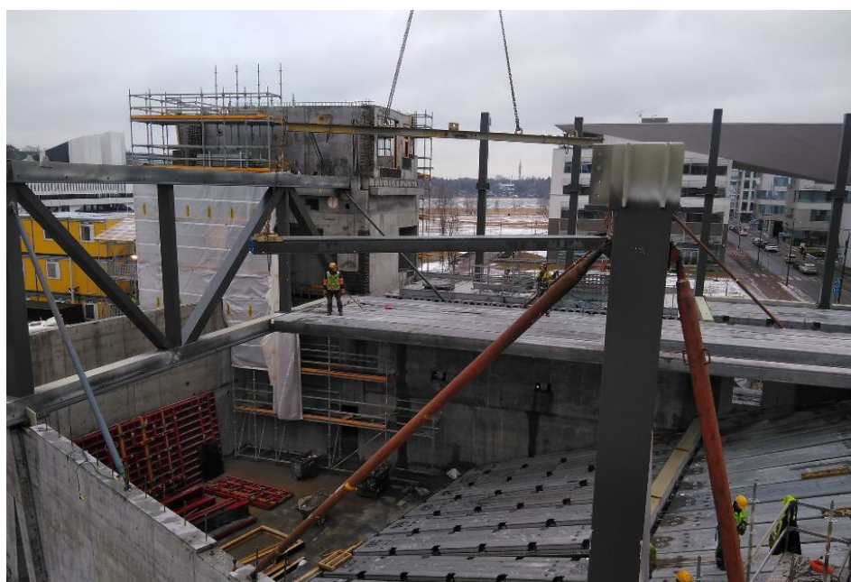
▪ Auditoriet er et søjlefrit rum. To kraftige gitre spændere mellem væggene og bærer etagen ovenover
