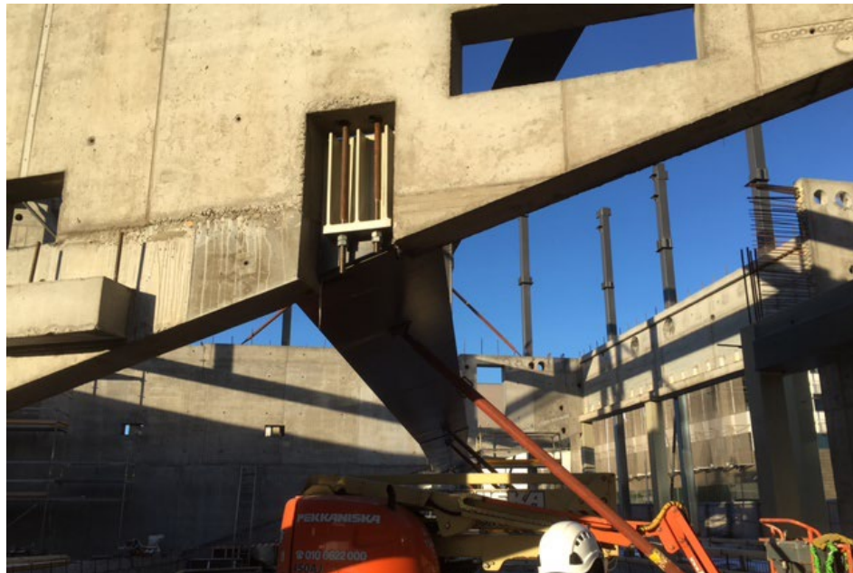
▪ Auditoriet er et søjlefrit rum. To kraftige gitre spændere mellem væggene og bærer etagen ovenover
