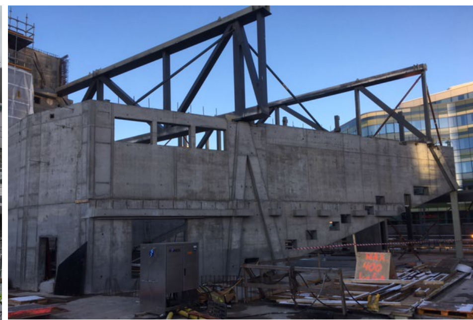
▪ Auditoriet er et søjlefrit rum. To kraftige gitre spændere mellem væggene og bærer etagen ovenover
