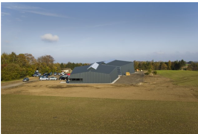
Landbrugsbyggeri med indlevelse og landskabelig tilpasning.
