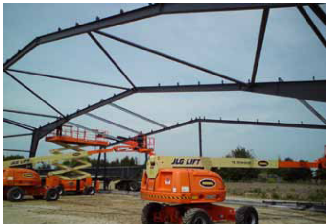
Fra stabilt underlag rejses stålrammerne. Hver enkelt ramme er forskellig. Rejsningen sker med hydrauliske lifte.
