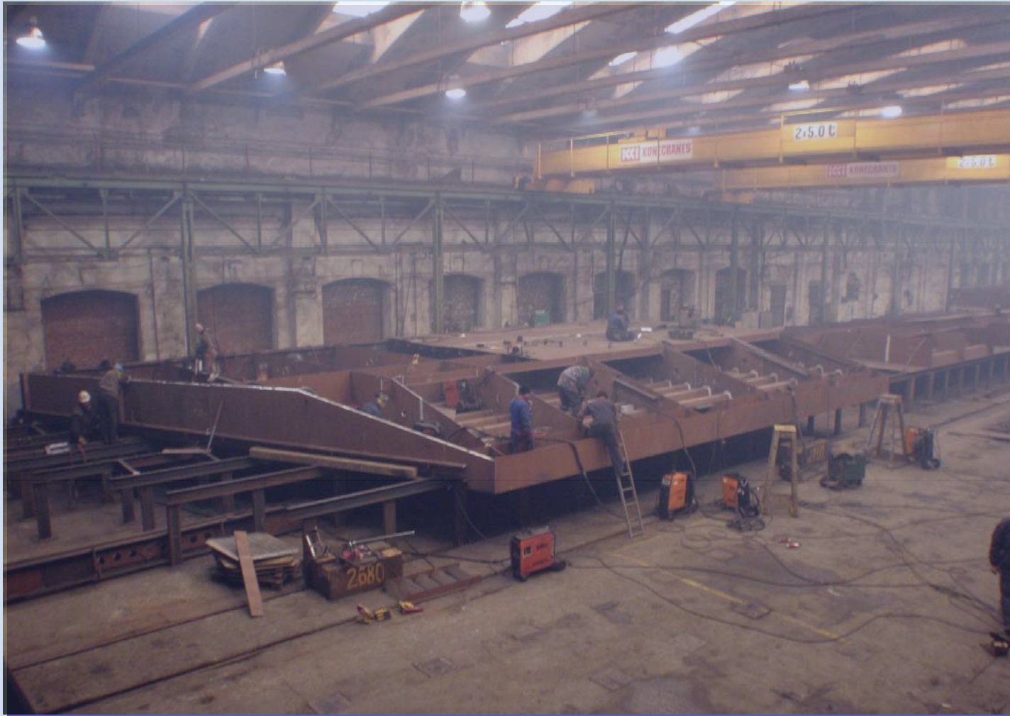
Forår 2010 Broelementer produceret i Tallin fragtes til samlepladsen
