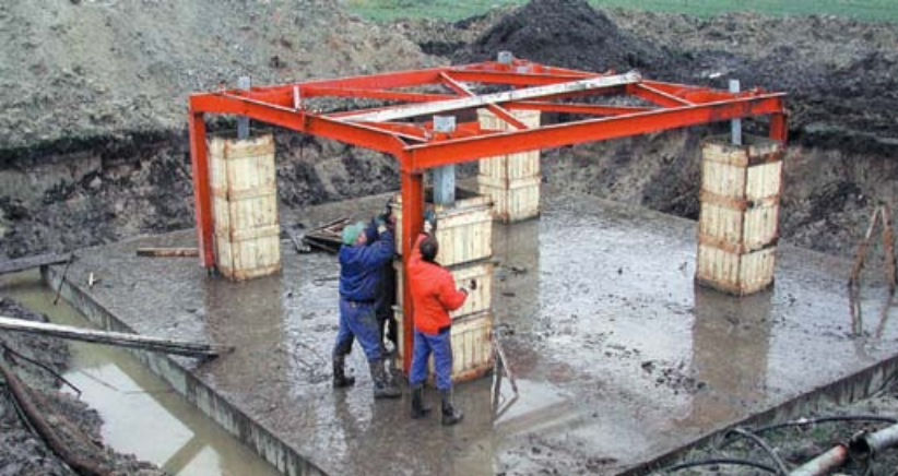
Traditionelt fundament i beton
