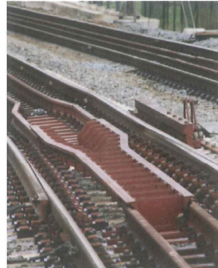
Compensatie-inrichting IJsselbrug, Zwolle.
