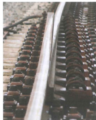
Detail tong en aanslagspoorstaaf.
