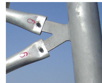
Eksempel på diagonal samling optimeret ud fra produktionsomkostningerne
