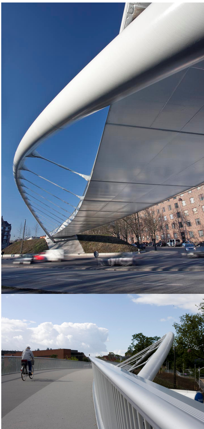
Figur 14. Den færdige bro. Foto Jon Norddahl
