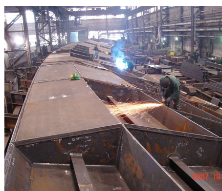
Figur 7. Hele brodrageren under opbygning hos smeden i Polen. Brodrageren er opbygget af kegleflader med plader på op til 30mm's tykkelse. Brodrageren blev opsvejt på hovedet på bukke, delt i to dele på tværs og i 3 dele på langs. Efterfølgende blev de 6 dele fragtet til Ågade og sammensvejt retvendt.
