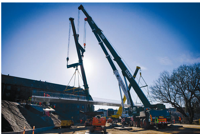
Figur 9. Brodrager på 220 tons løftes på plads med fire store mobilkraner. Foto Jon Norddahl
