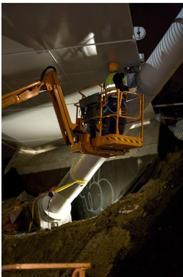
Figur 10. Montage af buen. Foto NIRAS. I forgrunden ses lejehylden på buen hvorpå et trykglideleje mellem brodrager og bue placeres. Foto Jon Norddahl/NIRAS
