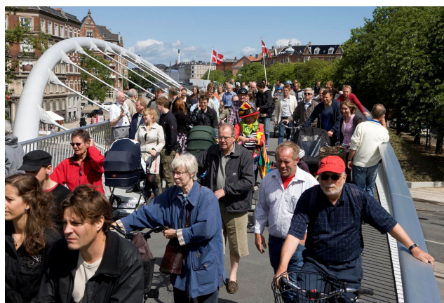
Figur 15. I en del lande er der tradition for at en bro "prøvebelastes" inden den tages i brug. En vellykket prøvebelastning skete umiddelbart under indvielsen. Foto NIRAS.
