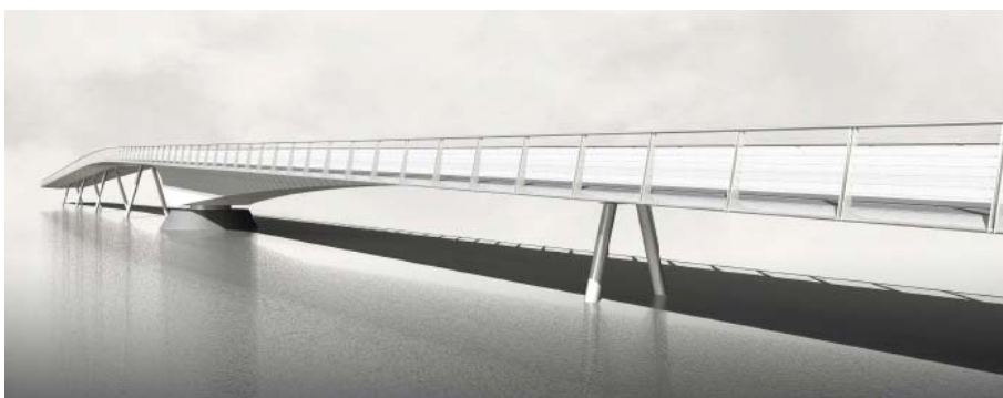
Stålets styrke har gjort det muligt at begrænse materialeforbruget til et minimum, så broen får et let, nærmest svævende udtryk.
