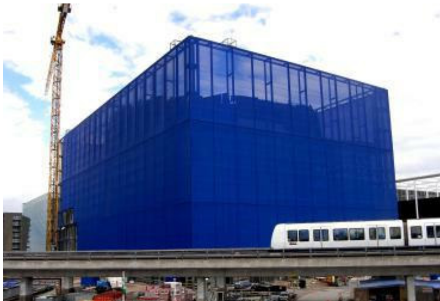
Koncerthusprojektet indeholder mange innovative og banebrydende stålkonstruktioner.
