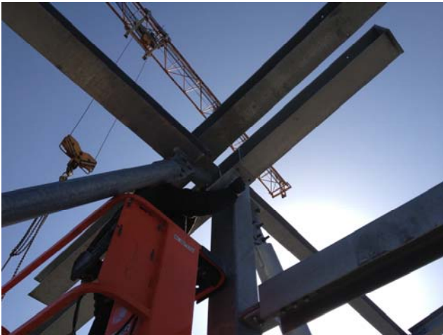
40 meter oppe monteres tagbjælker med tårnkran
